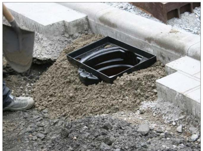
7. Grube lagenweise verfüllen und verdichten. Dabei unter dem Aufsatzrahmen Kegel aus Fundamentbeton aufbauen.
