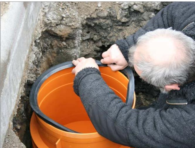
2. Dichtring aufsetzen.
