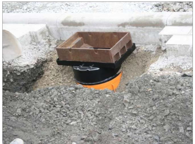
6. Hinter dem RainSpot mit Fundamentbeton verfüllen/hinterstopfen.
