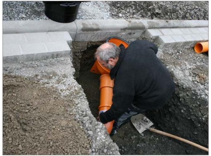
3. RainSpot mit dem Verbindungsrohr auf Fundamentbeton setzen.
