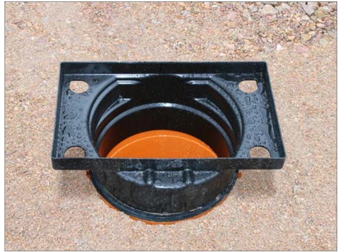
6. Rohrgraben / Grube verfüllen und verdichten
