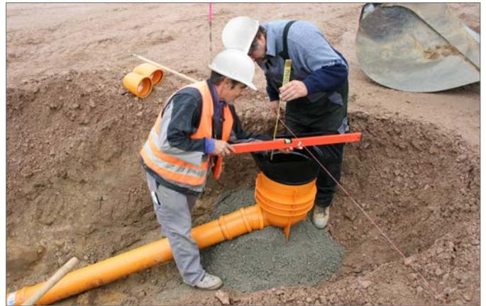
4. RainSpot mit Aufsatzrahmen erneut ausrichten.
