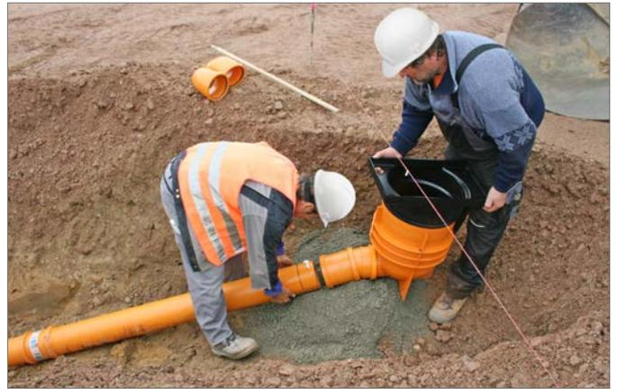
3. RainSpot mit Abflussrohr verbinden.
