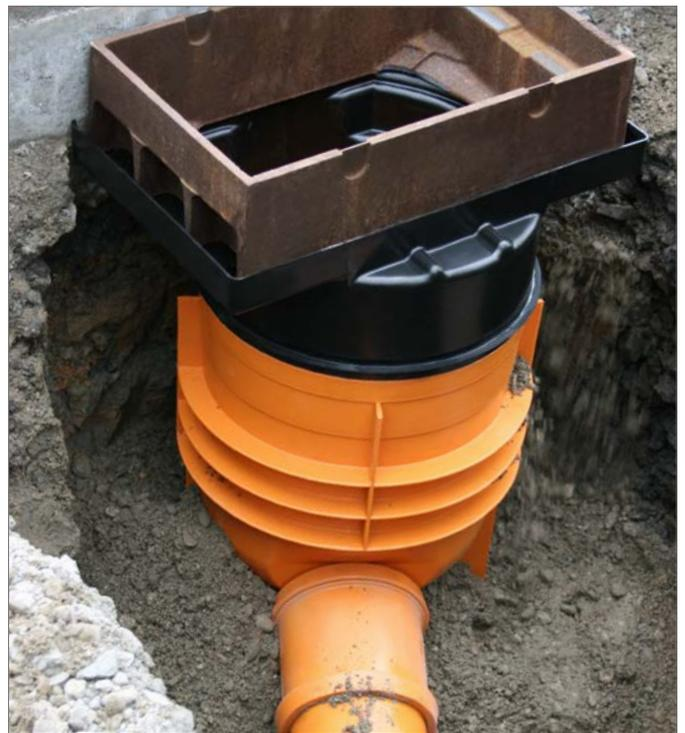
5. Gussaufsatz in den Aufsatzrahmen einlegen und RainSpot grob ausrichten.
