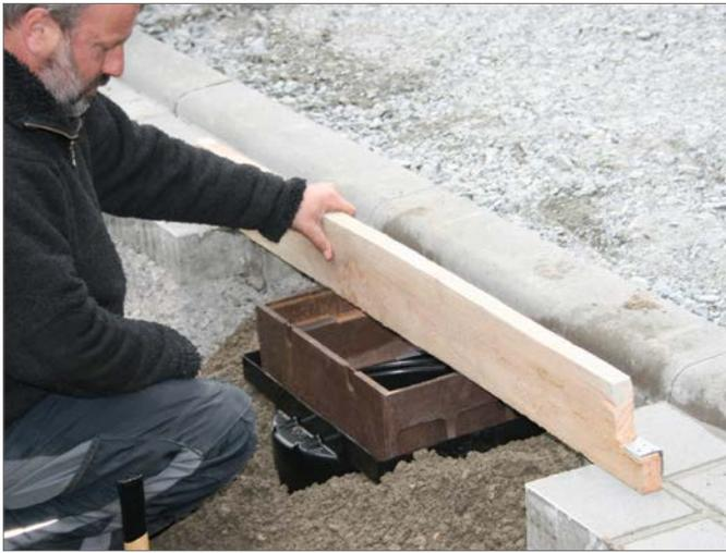
8. Den Aufsatzrahmen mit Fundamentbeton unterstopfen und Gussaufsatz auf die richtige Höhe bringen. Hierzu Aufsatzrahmen zunächst leicht überhöht einbauen (1-2 cm) und dann auf die gewünschte Höhe klopfen. Dabei muss der Fundamentbeton gut verdichtet werden. Ein nachträgliches Anheben des Aufsatzrahmens oder anderes Auflockern des Fundamentbetons ist unzulässig.
