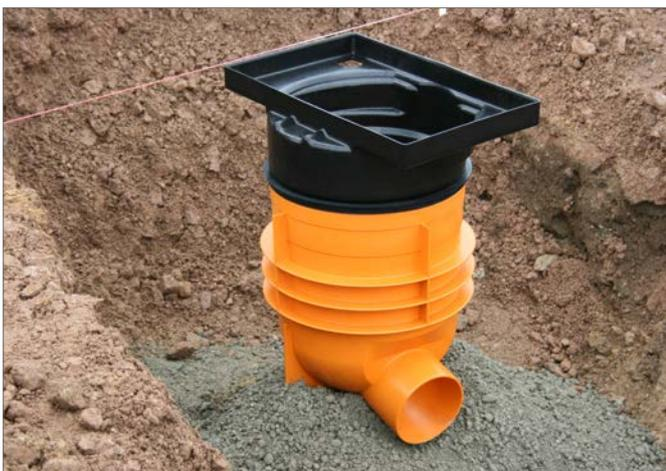
2. RainSpot auf Fundamentbeton setzen und grob ausrichten.
