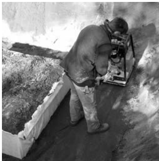
Compactage de l'espace de travail à côté du bassin.
