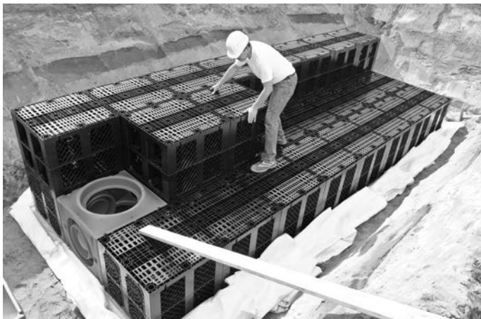
Einbau der RAUSIKKO Boxen
