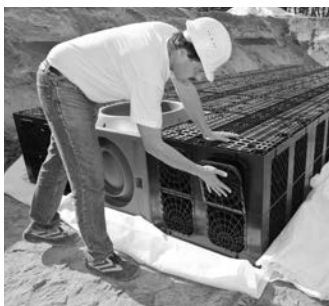
Einstecken der Frontgitter
