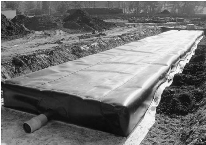
Zbiornik retencyjny osłonięty folią
