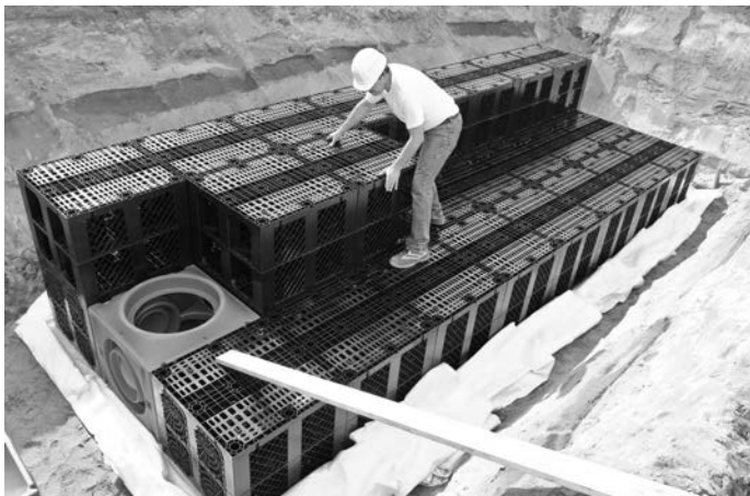
Montaż skrzynek RAUSIKKO Box
