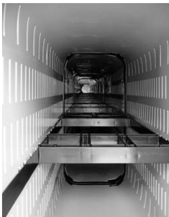
Płukanie wysokociśnieniowe kanału w skrzynce RAUSIKKO Box
