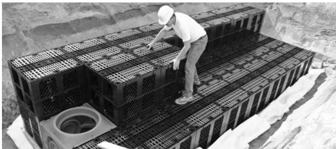
Pose des modules
