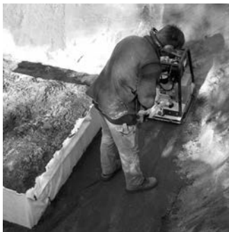
Utěsnění pracovního prostoru
