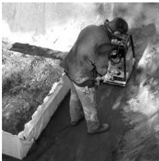
Compactarea spațiului de lucru
