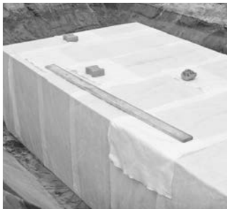
RAUSIKKO vsakovací galerie s filtračním rounem RAUMAT.
