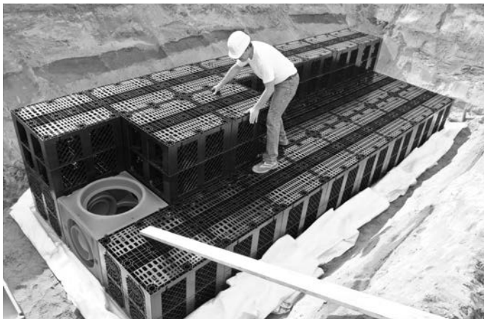
Pokládka RAUSIKKO boxů
