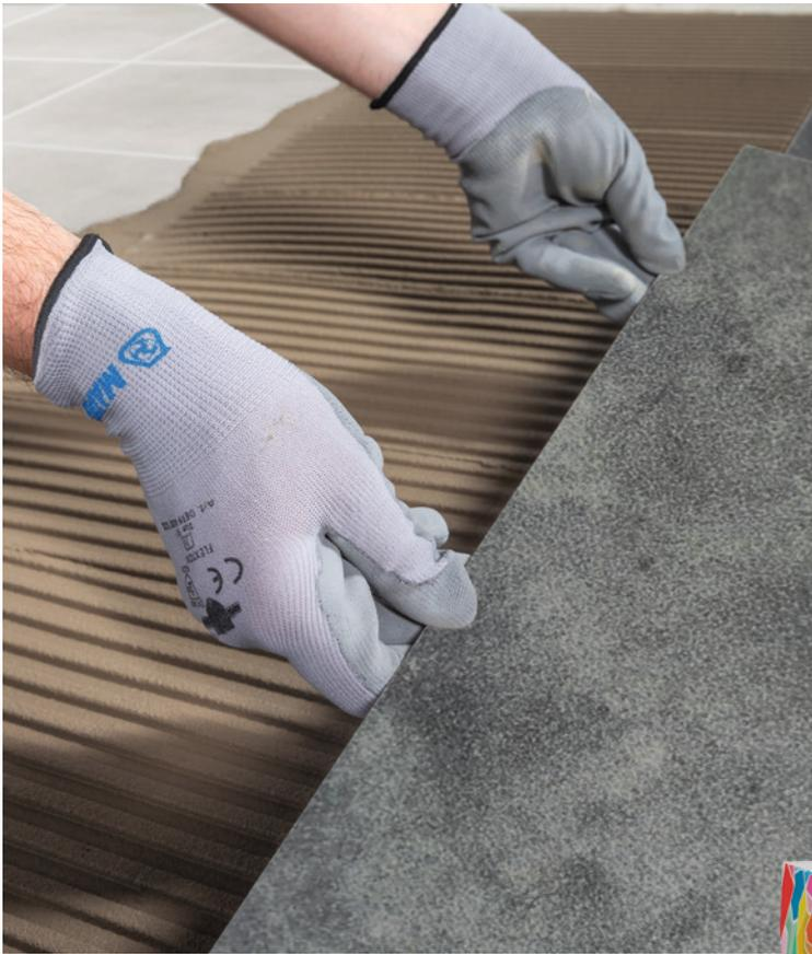
**Einkomponentiger, schnell abbindender und trocknender**, hochwertiger, **verformbarer**, zementärer **Leichtverlegemörtel** mit verlängerter Offenzeit und höchster Ergiebigkeit.
