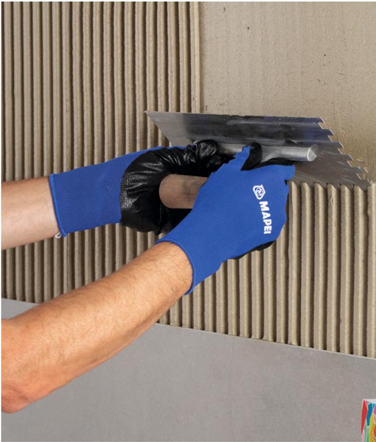
**Einkomponentiger, hochwertiger, stark verformbarer, zementärer Leichtflexverlegemörtel** mit verlängerter Offenzeit und höchster Ergiebigkeit.
