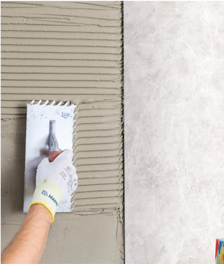
**Einkomponentiger, schnell abbindender und -trocknender**, hochwertiger, **stark verformbarer**, zementärer **Leichtverlegemörtel** mit verlängerter Offenzeit und höchster Ergiebigkeit.
